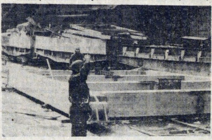
Tak powstaje skip zupełnie nowj konstrukcji. Fot. ST. GAWLIŃSKI
