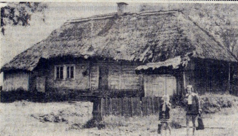
Na terenie Nowej Huty znajdują się także tak ciekawe zabytki, jak ta stara, strzecha kryta chata w Mogile. Władze dzielnicy powinny się zainteresować tym rzadkim już dzisiaj okazem ludowej architektury, aby w przyszłości (chata jest jeszcze zamieszkała) zorganizować tu coś w rodzaju skansenu, ciekawie kontrastującego z nowoczesnym budownictwem... (okt)
