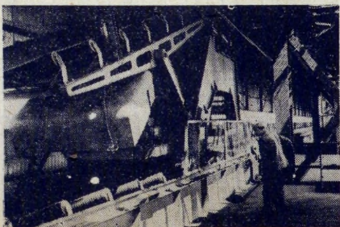
Fragment urządzeń transportera rudy w Aglomerowni II.
