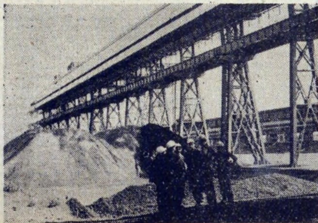
W tym małym plenerze odbywa się narada wykonawców i przyszłych użytkowników Aglomerowni II. Na dalszym planie składowisko rudy.
