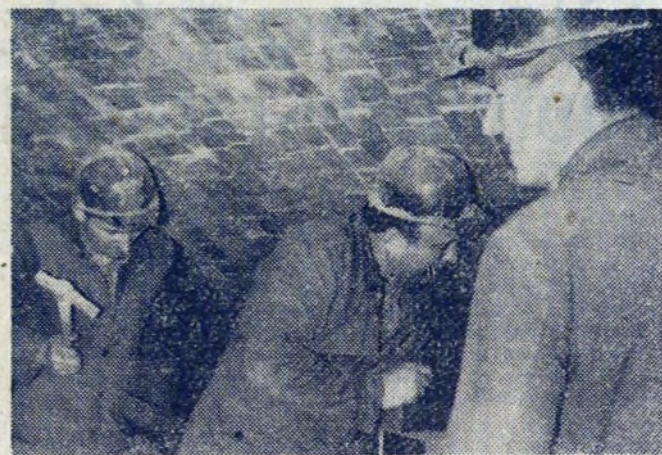
Ostatnie prace przy wymurówce marteny nr 5. Biali murarze HPR-u w akcji. Foto: ST. GAWLIŃSKI
