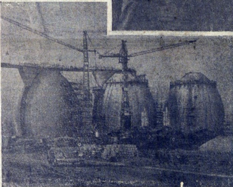
Zbiorniki pokazane na zdjęciu, to nie jajka wielkanocne. Są to olbrzymie zbiorniki z żelazo-betonu, znajdujące się w chwili obecnej w budowie niedaleko Hamburga. Mają one służyć do celów odmulania i oczyszczania wód ściekowych miasta Hamburga.
