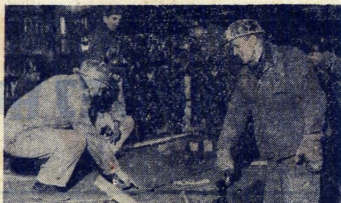
Przy układaniu bloków węglowych.
